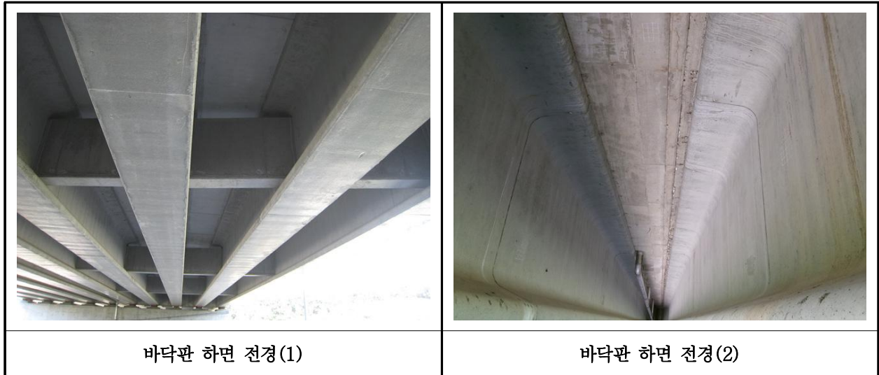
【사진 32.3.2】 바닥판하면 전경
