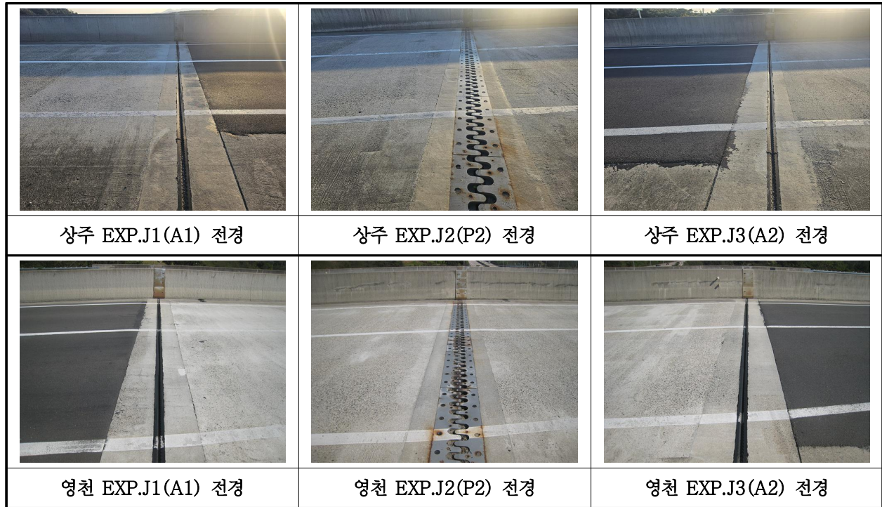
【사진 32.3.16】 신축이음장치 전경
