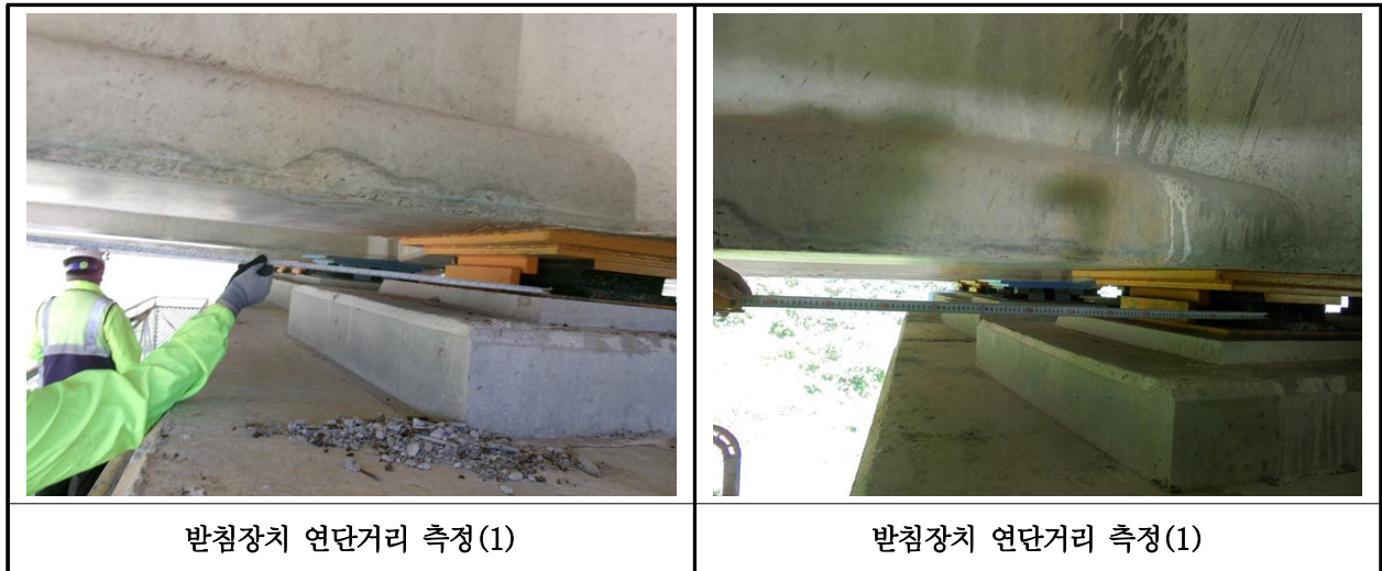
【사진 32.3.14】 교량받침장치 연단거리측정
