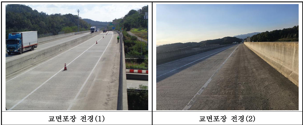
【사진 32.3.19】 교면포장 전경
