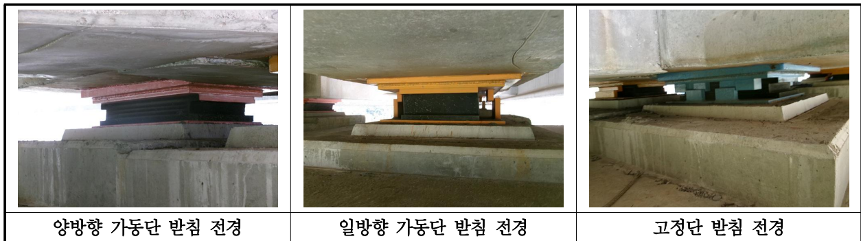
【사진 32.3.12】 교량받침 전경
