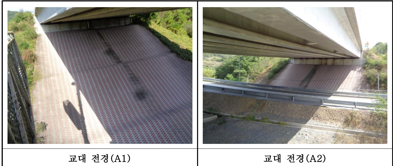
【사진 32.3.8】 교대 전경
