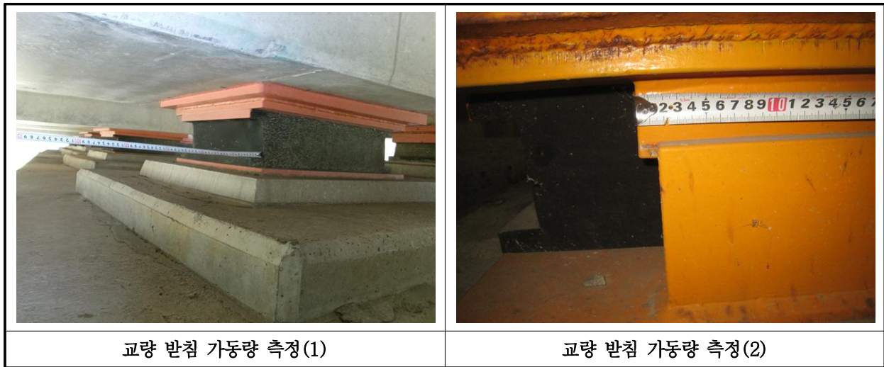
【사진 32.3.15】 교량받침 이동량 측정
